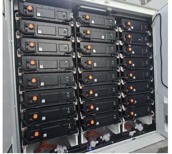
Orbit ESS içinde sıvı soğutmalı batarya paketleri
